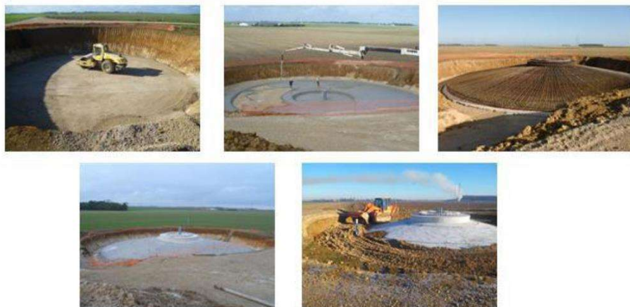
Photo 3. Fondations à différents stades d'avancement (Source : JPEE)
