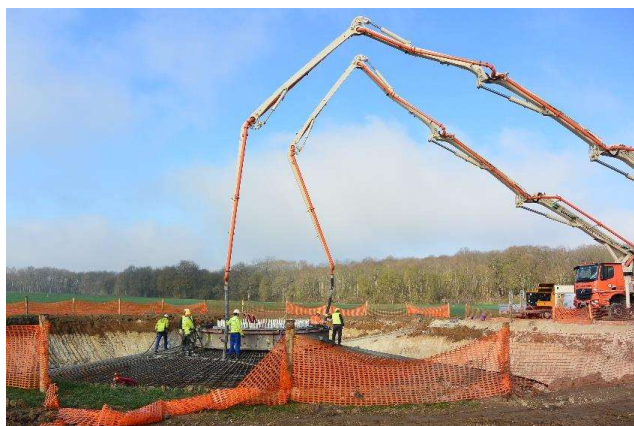
Photo 5. Coulage du béton au sein du ferrailage (Source : JPEE)
